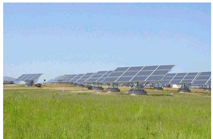
Phase One of 12 Megawatt Solarpark Gut Erlasse
